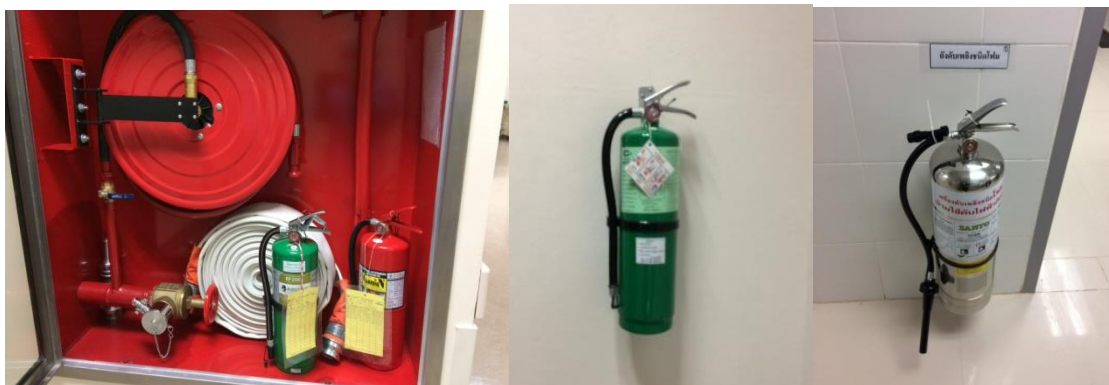
ภาพแสดง ตู้เครื่องดับเพลิง (Fire Hose) และเครื่องดับเพลิงมือถือ
