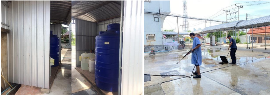
ภาพแสดง ถังเติมคลอรีนของระบบบำบัดน้ำเสียขั้นต้นของอาคาร โครงการและการเก็บตัวอย่างน้ำ
