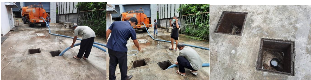
ภาพแสดงการสูบน้ำออกจากบ่อดักไขมัน
