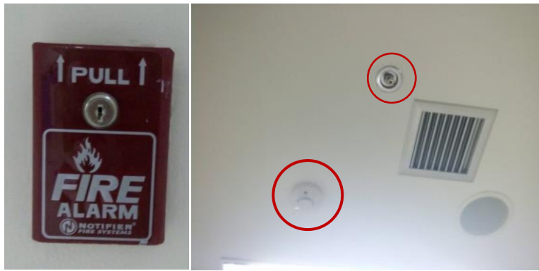
ภาพแสดง ระบบสัญญาณแจ้งเหตุเพลิงไหม้ (อุปกรณ์แจ้งเหตุด้วยมือ) อุปกรณ์เริ่มสัญญาณอัตโนมัติ (อุปกรณ์ตรวจจับควัน และอุปกรณ์ตรวจจับความร้อน
